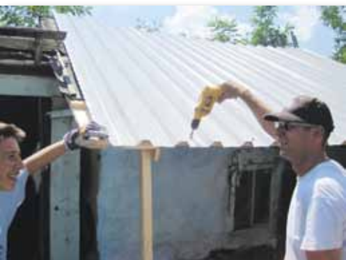
◀ Richard van der Pols; technische begeleiding Missiontrip (rechts) bezig met één van de IKN vrijwilligers om dakplaten te bevestigen op één van de huizen van de kansarme gezinnen.
