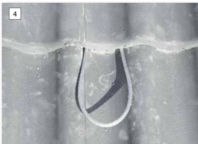
Er zijn geen aanvullende loodslabben of andere afdichtingen nodig zoals bij dakhaken..
