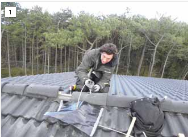
De eind- en tussenpunten worden met stevige schroeven op de ruiters geplaatst.
