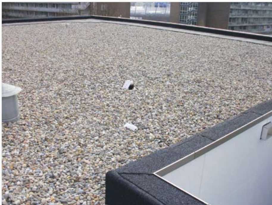
Penduleankeringspunt aangebracht naast sparing.
