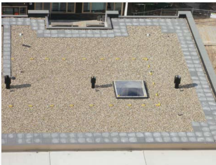
Niet doorvalbestendige lichtkoepel in veilige zone.
