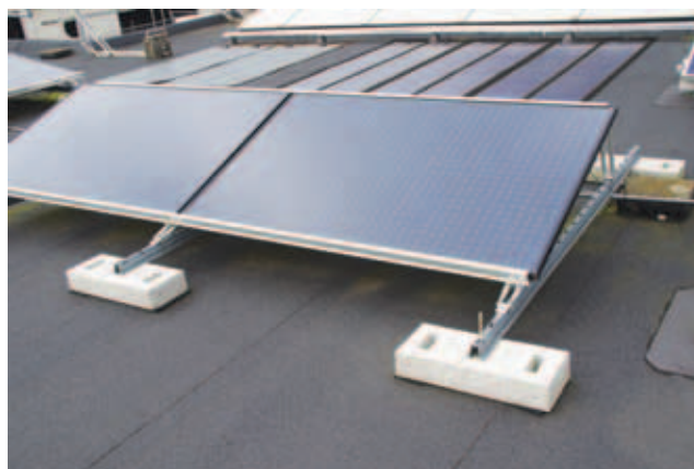
Voorbeeld van montagewijze 3; zonne-energiesysteem losgeplaatst en geballast.
