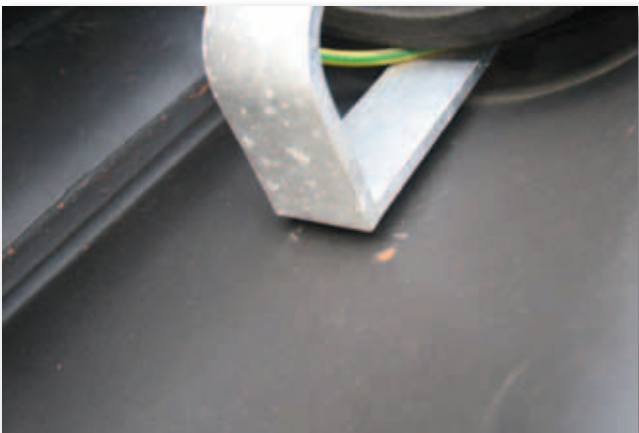
Het klapperen van de te lichte beugel maakt op den duur de dakpan stuk.
