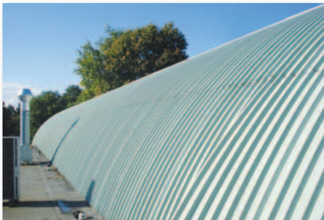
Het te onderzoeken dak betrof een metaaldak op een zwembad met de navolgende opbouw:
