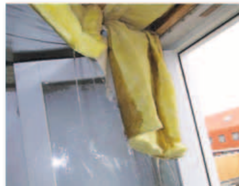
Figuur 7a: Deze hoeveelheid water* is NIET het gevolg van condensatie door lucht lekkages. Nee, hier is sprake van bouwvocht.
