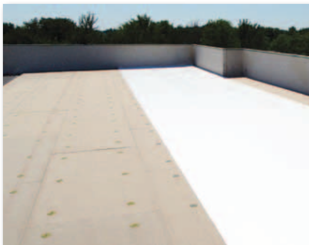
RhinoBond drukverdeelplaatpatroon: dezelfde bevestigers worden tegelijkertijd gebruikt voor de isolatie en de dakbaan
