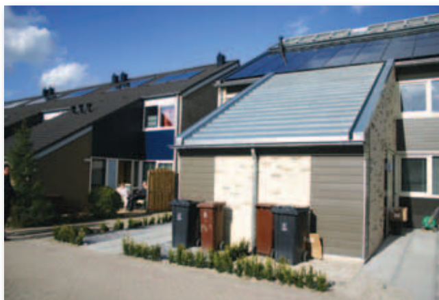
De voorzijde van de Poorters van Montfoort. Links is zichtbaar hoe de woningen er vóór de renovatie uitzagen.
