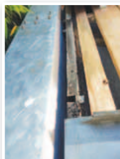
Aanhaking aan voet geopend met onvoldoende dekking; hechthouten strook zwart van vocht indringing.
