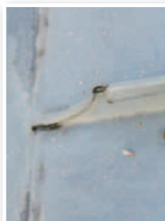
Aanhaking gootzijde nog gesloten.
