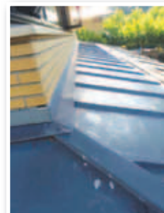
Vaste montage profiel op felsen over 11 m.
