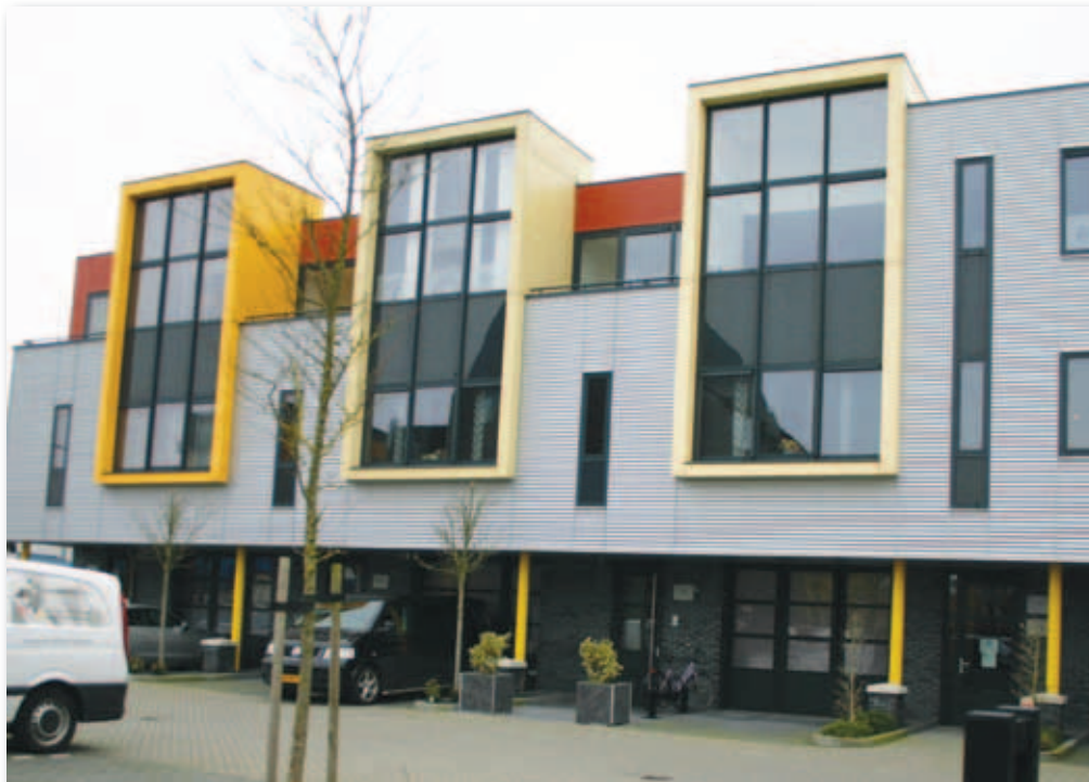
De nieuwe locatie van dakmerk aan de Wiersedreef in Nieuwegein.
