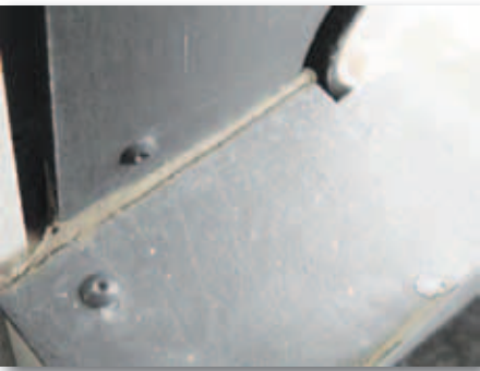
5. Kit afdichting gescheurd.
