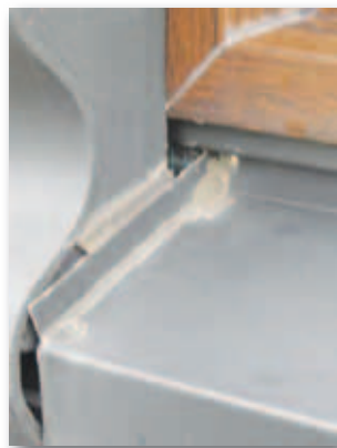
16. Aansluiting venster- waterslag en B-onderstuk met wat kit en aanzienlijk 'gat'.
