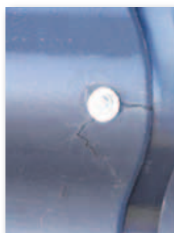
12. Door optredende spanning grote scherven uit einde golfplaten.
