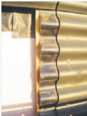
1. Naadafdichting middels polyester profiel.
