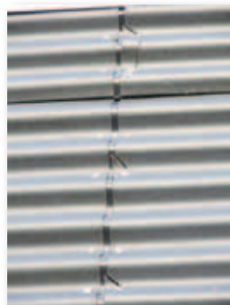
12. Door optredende spanning grote scherven uit einde golfplaten.
