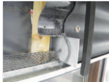
2. Afgebroken profiel met kit naad tegen stalen flens tegenstrooms afgewerkt.
