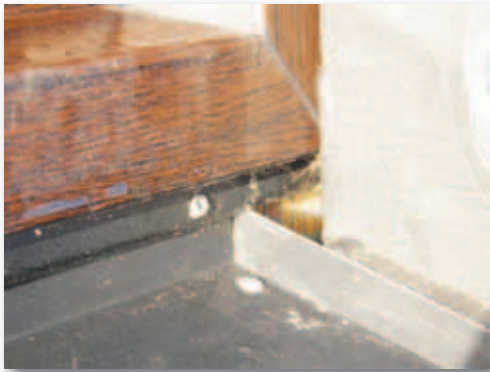
16. Aansluiting venster- waterslag en B-onderstuk met wat kit en aanzienlijk 'gat'.
