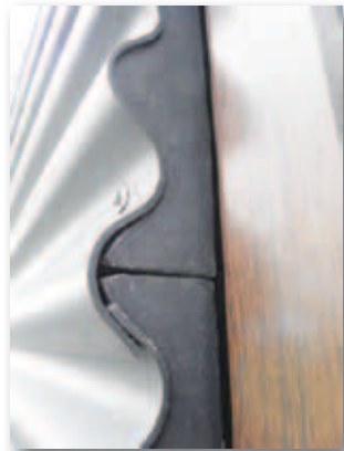
11. Montage met 8 bevestigings per plaat. >
