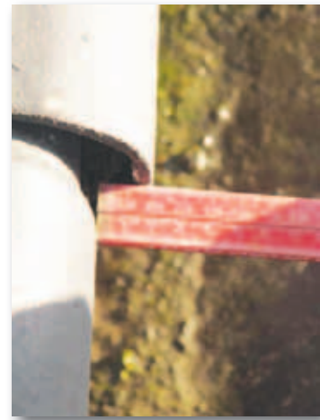
20. 20 mm hoogteverschil in montage van S-windveer hulpstukken. >
