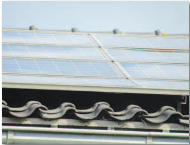
Systeem golft over het dak.
