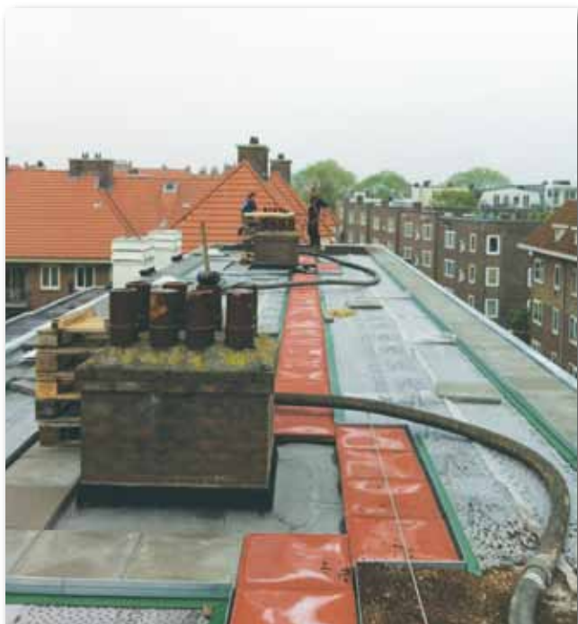
De aanleg van het groendak.
